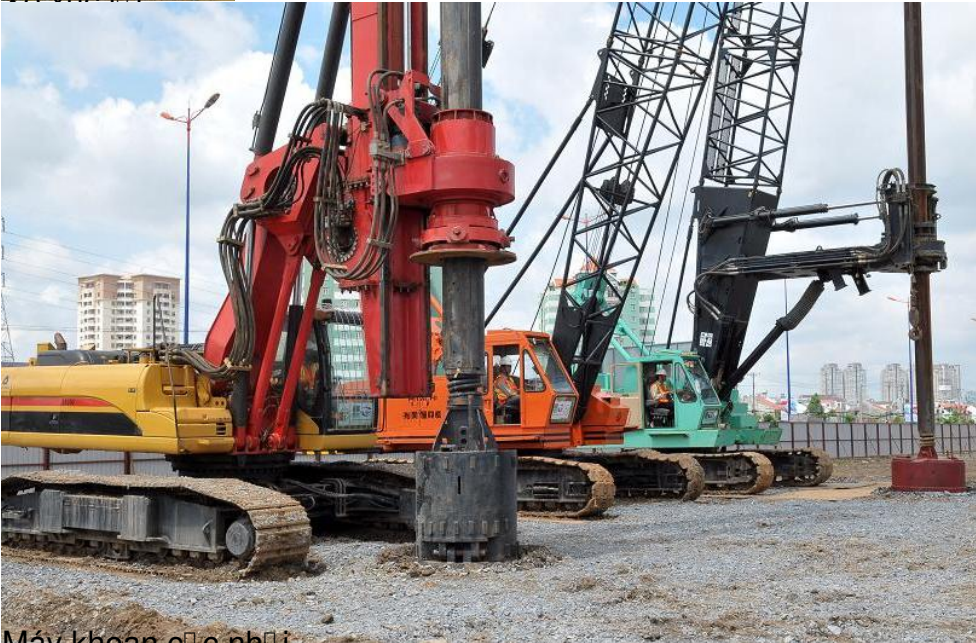
Máy khoan cọc nhồi
