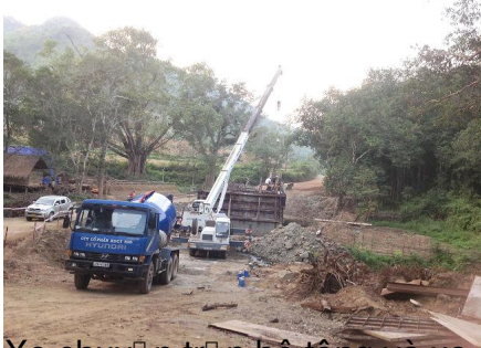
Xe chuyên chở bê tông và xe cẩu công trình
