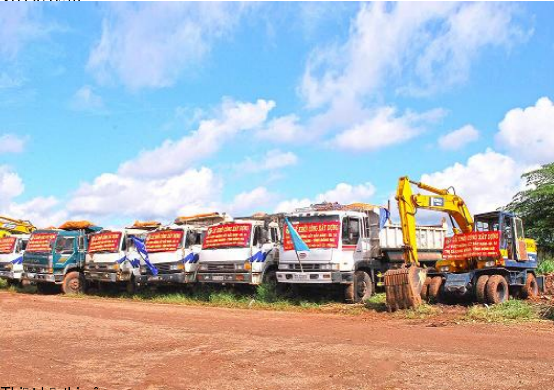
Thi công thi công
