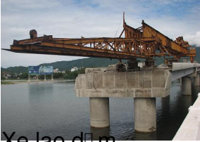
Xe lắp đặt
